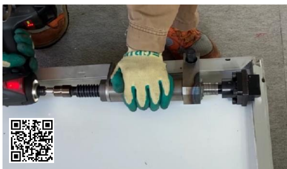
《アルミフレーム分解作業》
